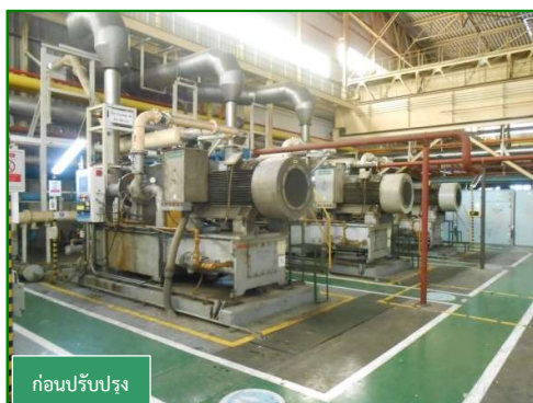
ภาพที่ 3.56 การจัดทำห้องกันเสียงบริเวณ Air Compressor
