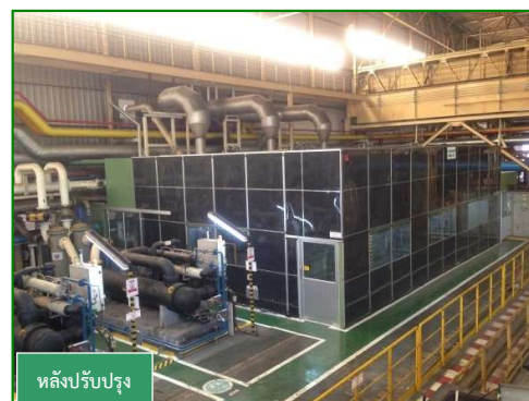
ภาพที่ 3.56 การจัดทำห้องกันเสียงบริเวณ Air Compressor
